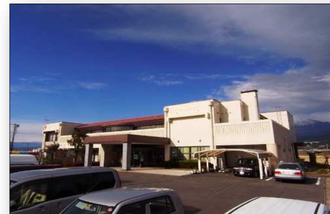
社会福祉センター東部市民プラザ（昭和63年）
