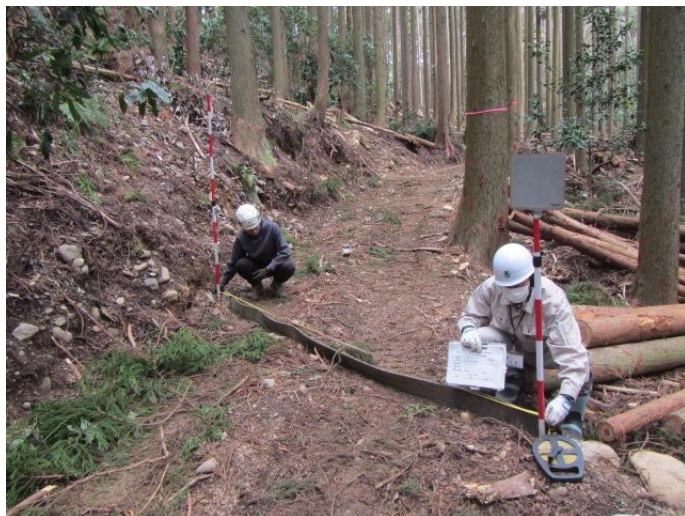
開設した作業道の様子
