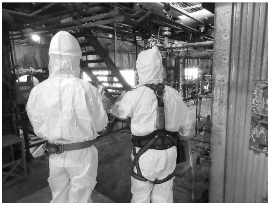
特定粉じん排出等作業立入検査の様子（防護服着用）
