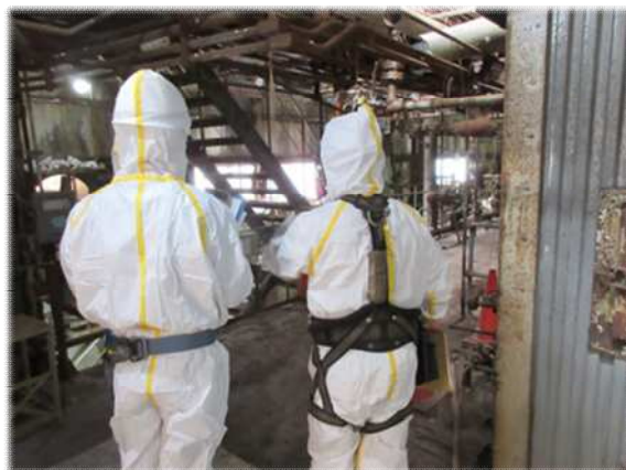
特定粉じん排出等作業立入検査
