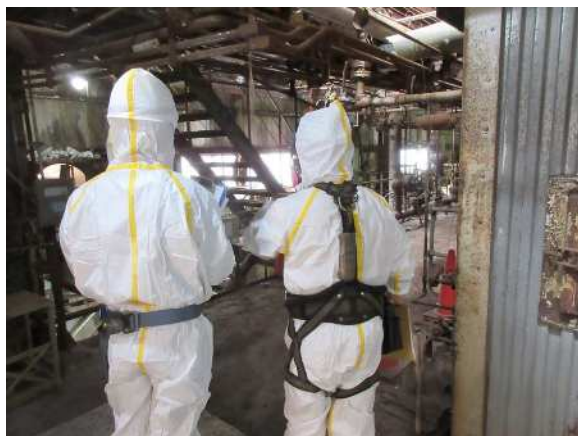
特定粉じん排出等作業立入検査
