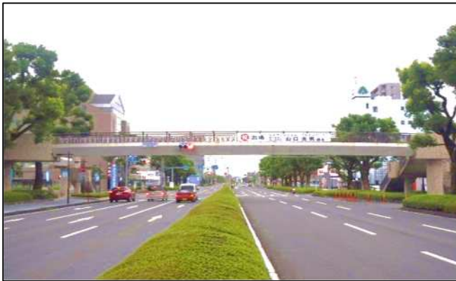
【鋼橋】富士市役所前歩道橋
