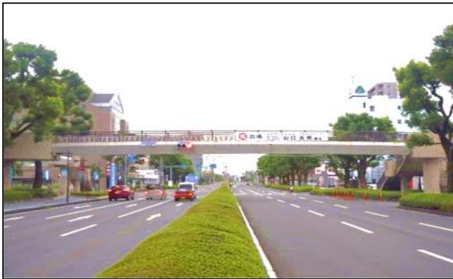
【鋼橋】富士市役所前歩道橋
