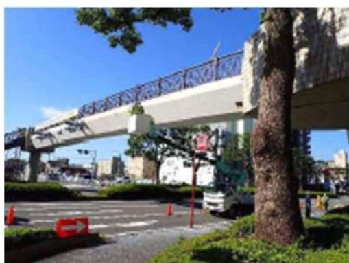
写真 高所作業車による点検状況 (市役所前歩道橋)
