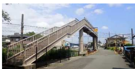
浅間跨線人道橋
