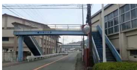
富士川第二小歩道橋
