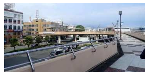
富士駅北口歩道橋
