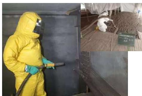
図 4.1.4 新技術によるケレン事例
