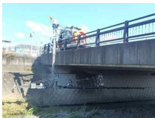
写真 新技術による点検状況
