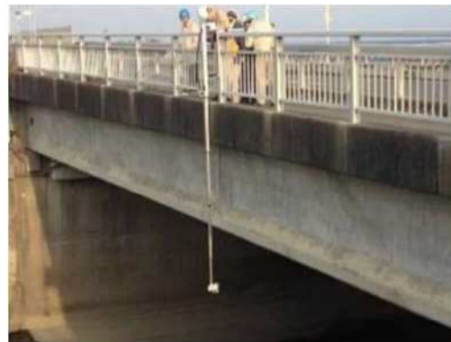
写真 4.1.2 技術現場での点検作業に対する新技術（例：ロボットカメラ）
