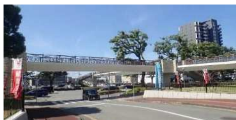
市役所前歩道橋
