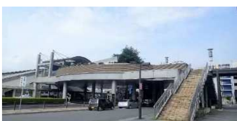
富士駅南口歩道橋
