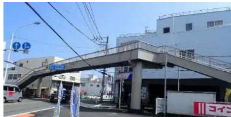
加島町歩道橋
