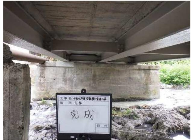
3053\_富安橋(R3) ひび割れ・漏水を生じたゲルバーヒンジの吊桁補強前後の状況
