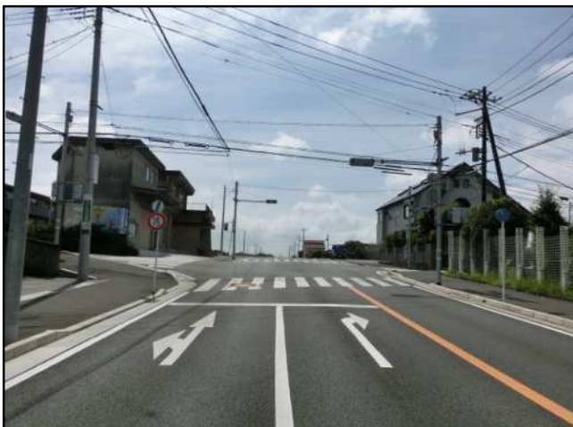
【完成写真】矢印①の方向から撮影
