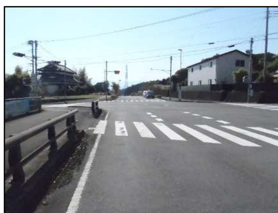
【完成写真】矢印②の方向から撮影
