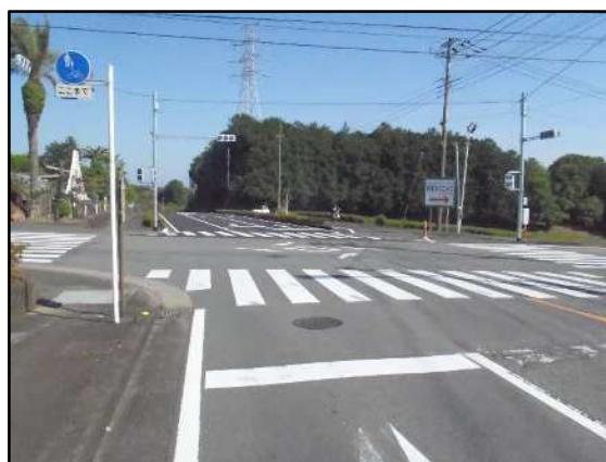
【完成写真】矢印①の方向から撮影
