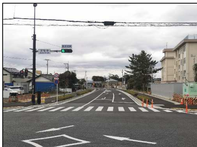
【完成写真】矢印の方向から撮影
