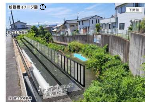
伝法沢橋右岸から下流側を撮影
