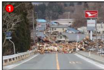
岩手県宮古市国道 45 号の被災状況
