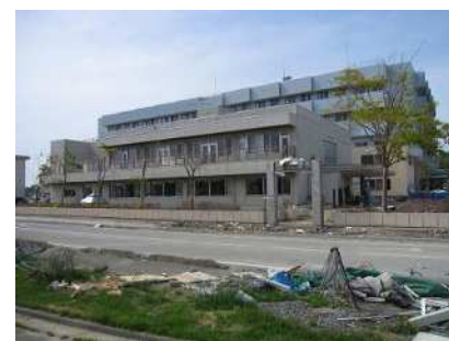
津波により被災した病院施設
