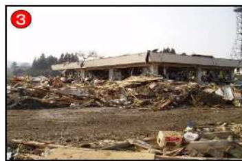
気仙沼国道維持出張所の被災状況
