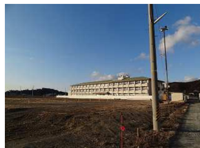
工事が遅れている復興事業用地
