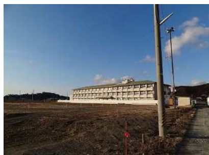
工事が遅れている復興事業用地
