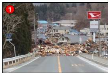
▲岩手県宮古市国道45号の被災状況
