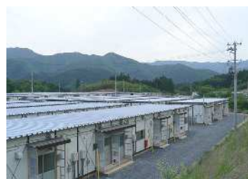
仮設住宅（建設型）の例（大船渡市）
