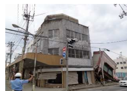
地震により被災した商店街
