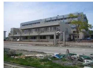
津波により被災した病院施設
