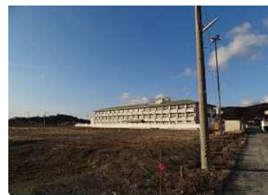
工事が遅れている復興事業用地
