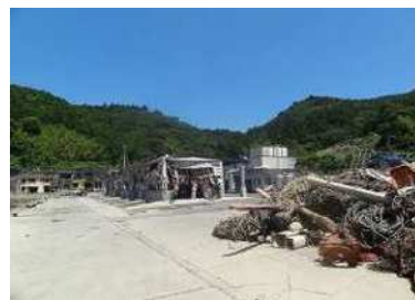
津波により被災した漁港施設
