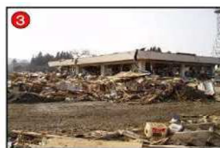
気仙沼国道維持出張所の被災状況
