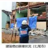
建築物の損壊状況（七尾市）
