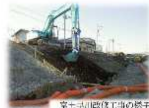
室七早川改修工事の様子
