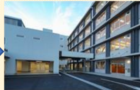
長寿命化改修+新築
