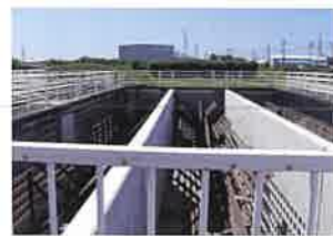
沈殿池の歯車 水を静かに動かして、汚れを沈めます
