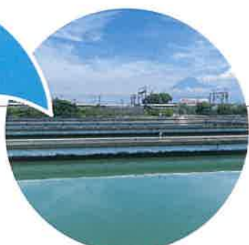
浄水場の様子
