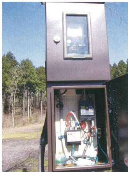
電源の確認2(落雷時)
