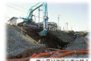
富士早川改修工事の様子
