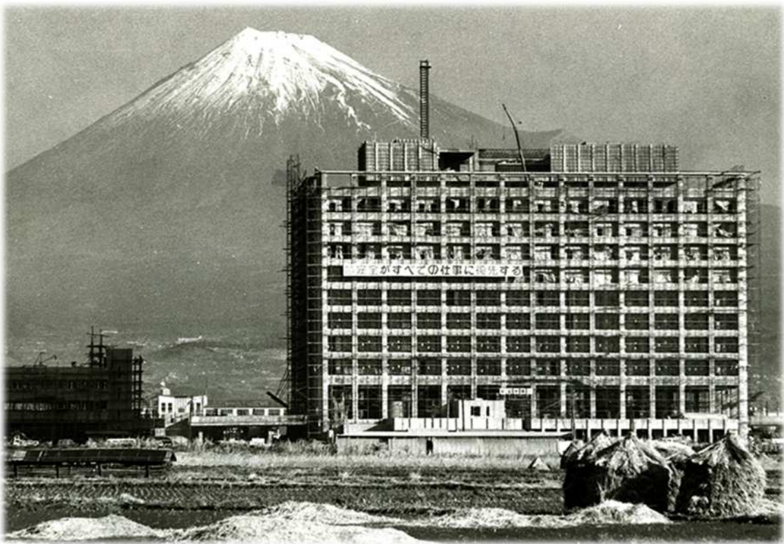
市庁舎建設工事 昭和44年12月23日
