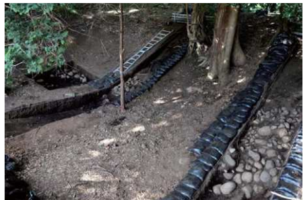
【写真2】前方部側面の崩落石の状況
