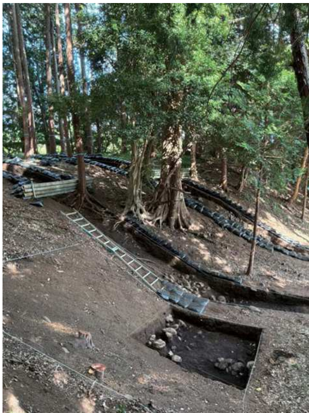
【写真1】くびれ部から前方部側面の崩落石の状況
