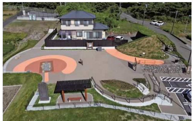
▲整備完成状況（南から）
