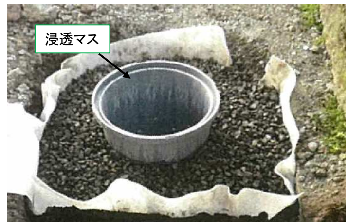
B型埋設施工例
