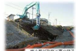
富士早川改修工事の様子
