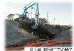
富士早川改修工事の様子
