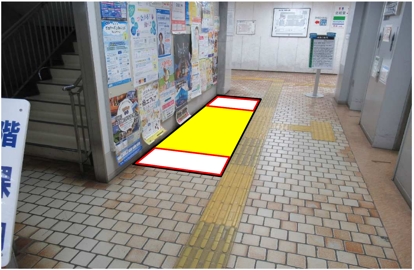
設置場所③ 本庁舎 1階エレベーターホール
