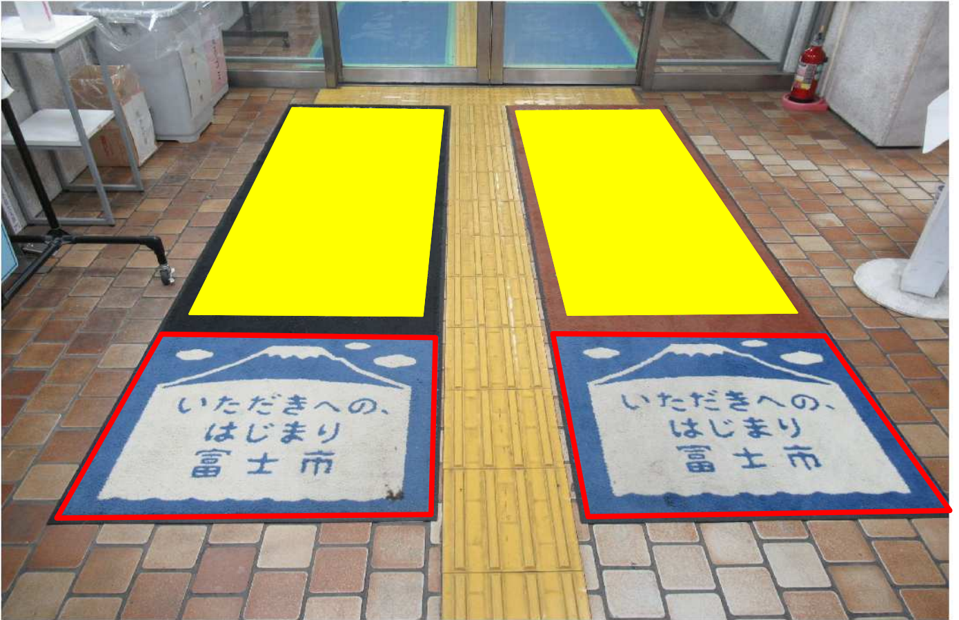
設置場所① 市庁舎 1階 西口（風除室）
