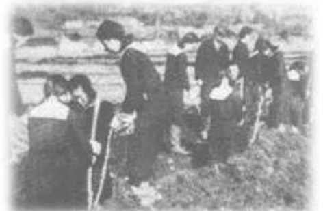
暗渠排水工事
