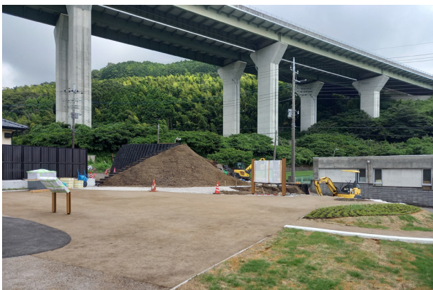
墳丘盛土と敷地舗装状況（南西から）
