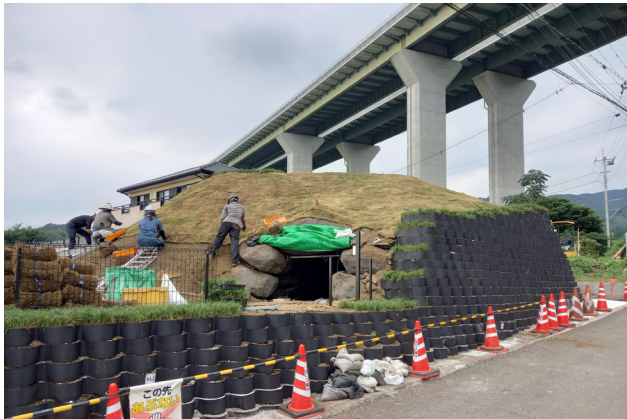
千人塚古墳 墳丘植栽工（南東から）
