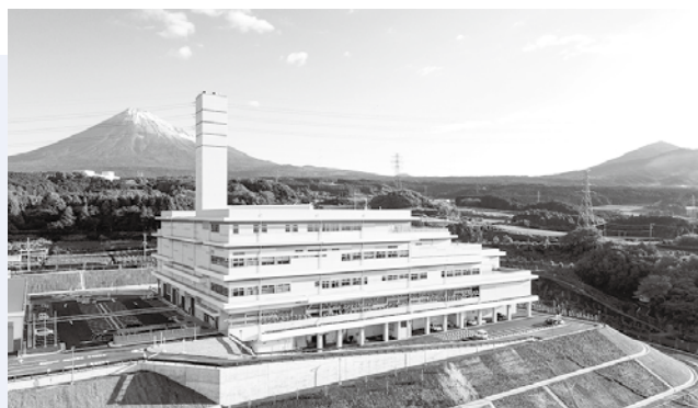
▲新環境クリーンセンターの工場棟
