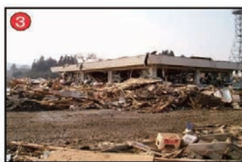
気仙沼国道維持出張所の被災状況
