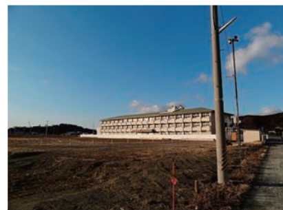
工事が遅れている復興事業用地
