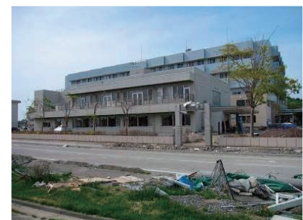
津波により被災した病院施設
