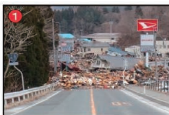
岩手県宮古市国道 45 号の被災状況
