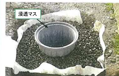
B型埋設工事例
