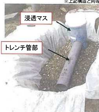
A型埋設工事例(手前の筒型部がトレンチ管部です)
