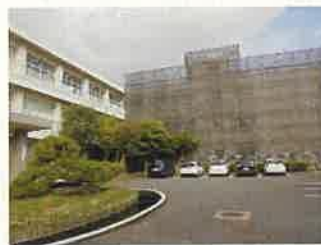
改修中の南校舎
