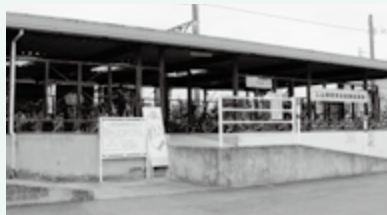
ワースト2 入山瀬駅南自転車駐車場
