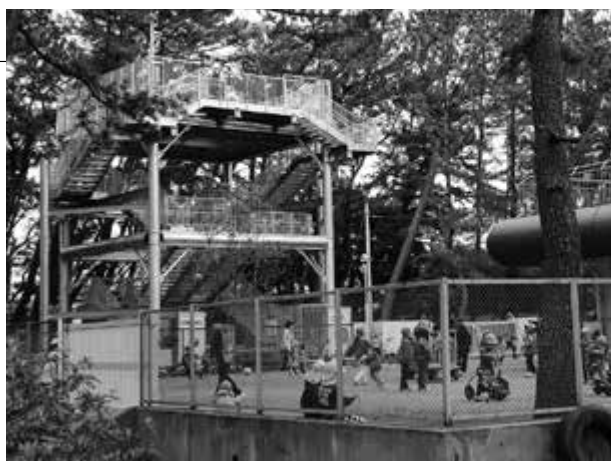
▲浜保育園西側の津波避難タワー。太陽光発電式LED照明も備えられている
