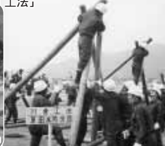
堤防の漏水を防止する「月の輪工法」
