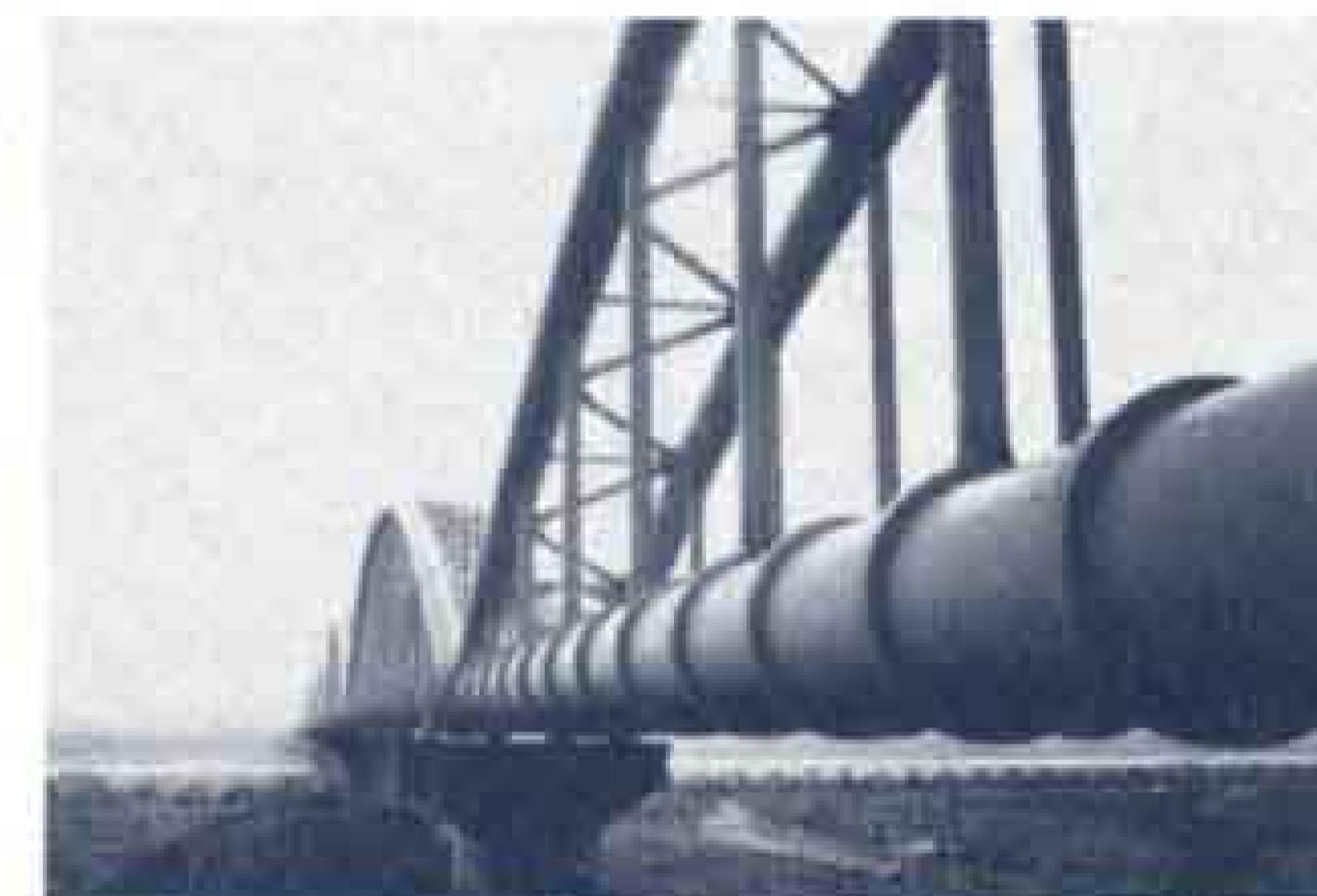
富士川の工業用水管橋は、日鉄金の発電所放流水を東駿河湾工業用水道として厚原の浄水場へ送っています。その量は、1日平均44万6,000立方メートルです。
