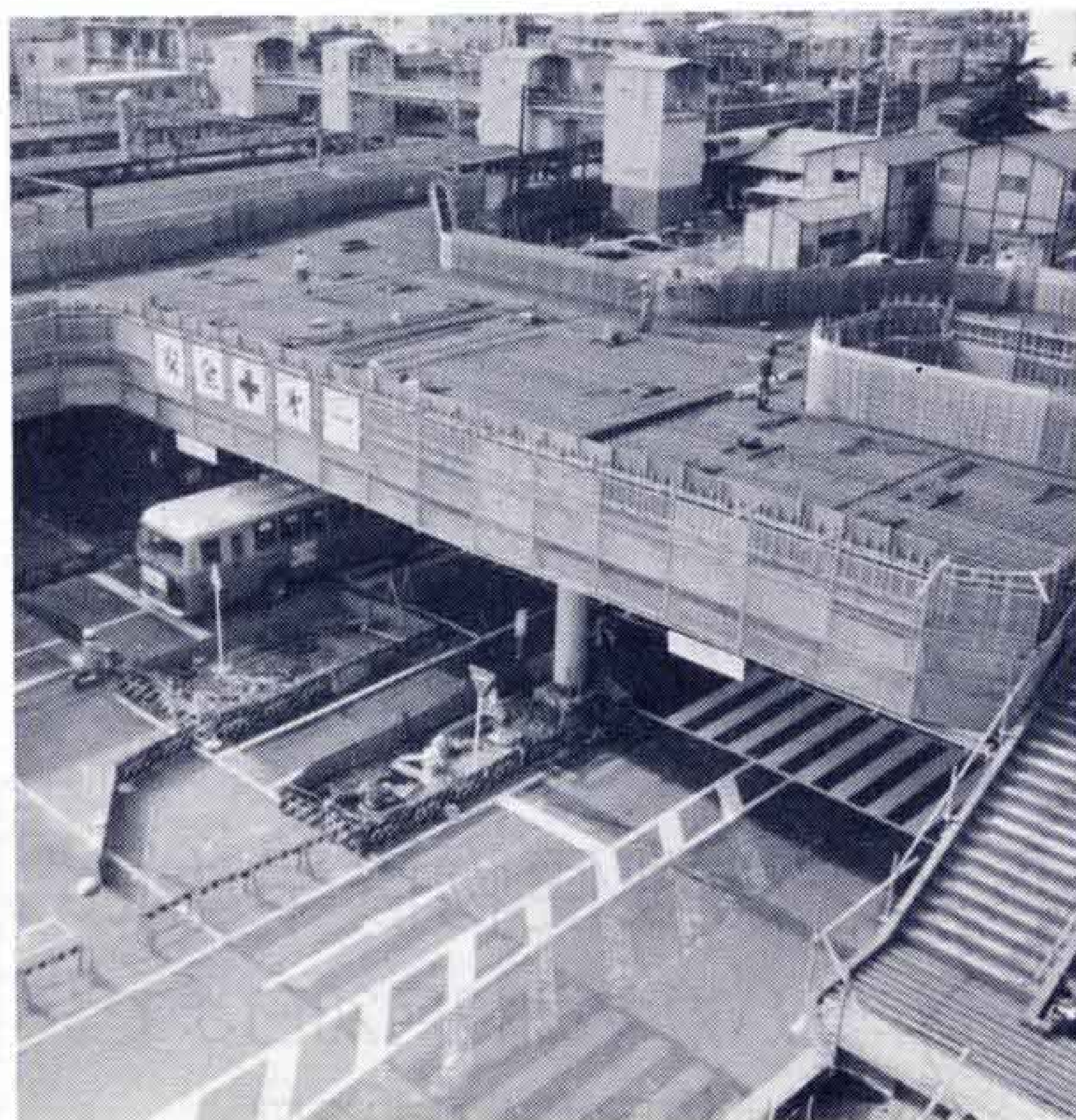
来年3月完成予定の北口歩道橋 (富士駅周辺区画整理事業)
