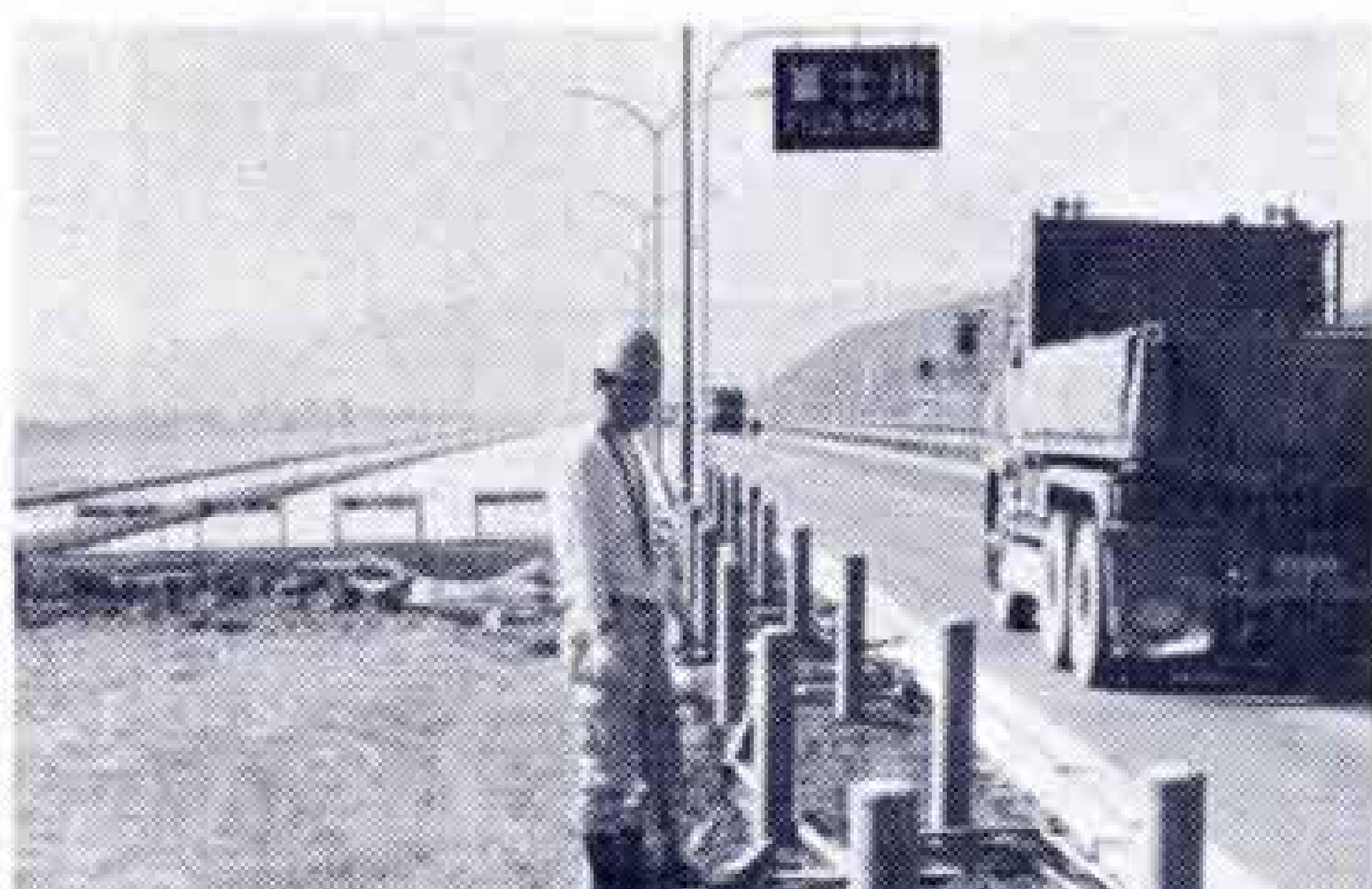
拡幅された新富士川橋
