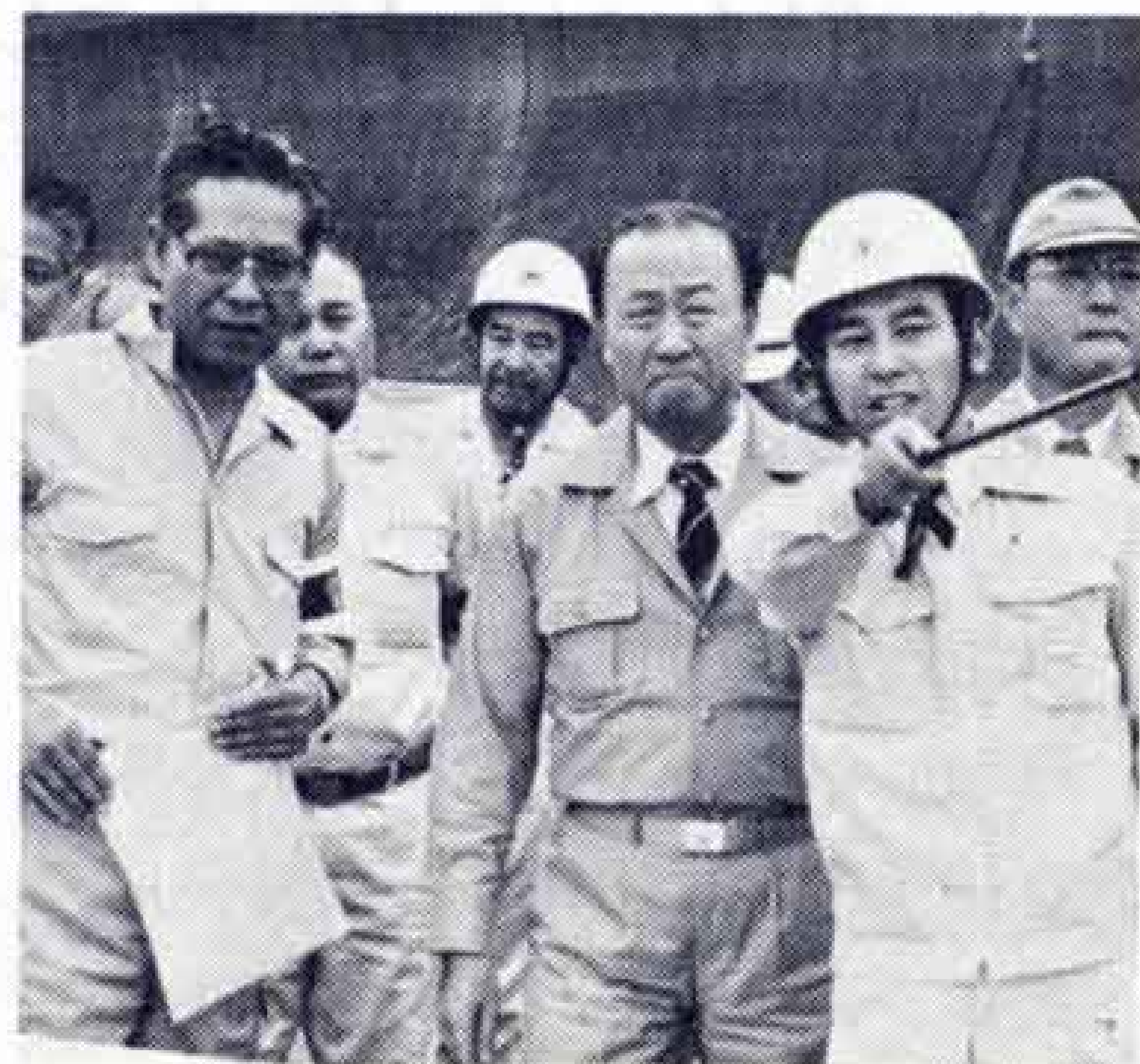
海岸侵食防止工事の説明を受ける 斉藤建設大臣（中央）
