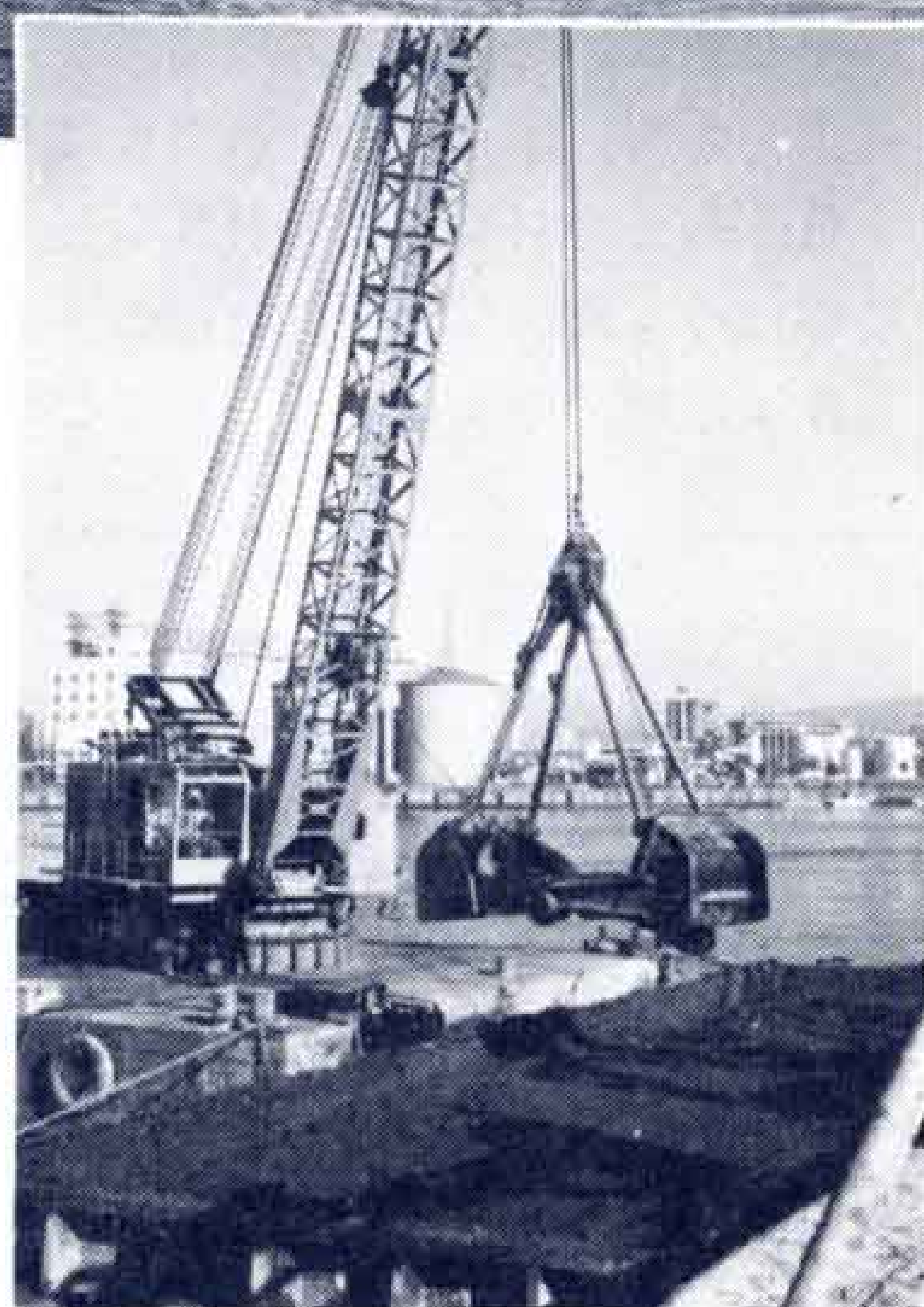
【セメントを混ぜ固める作業】
