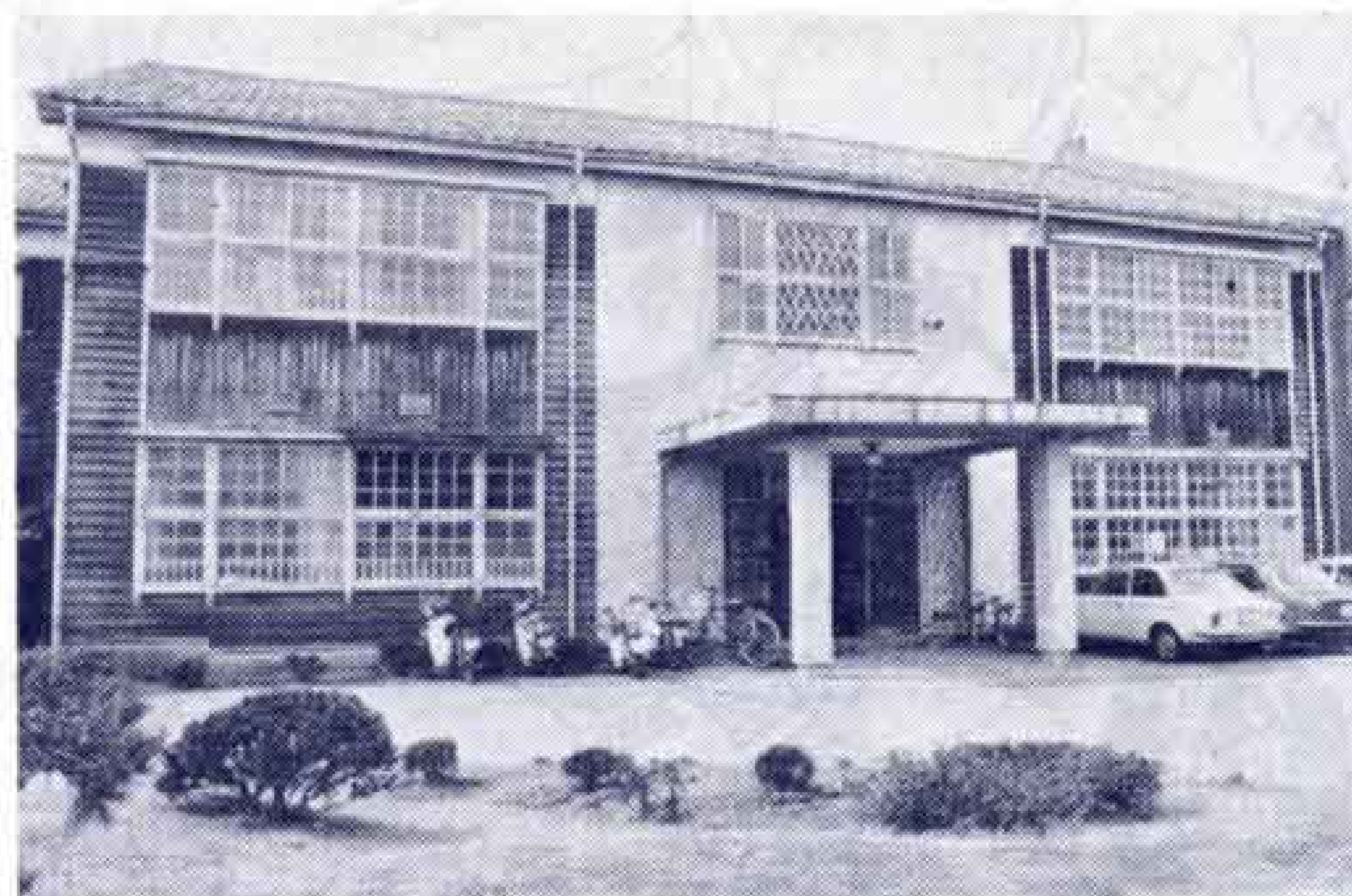
【吉原第1中学校の新改築を行ないます】
