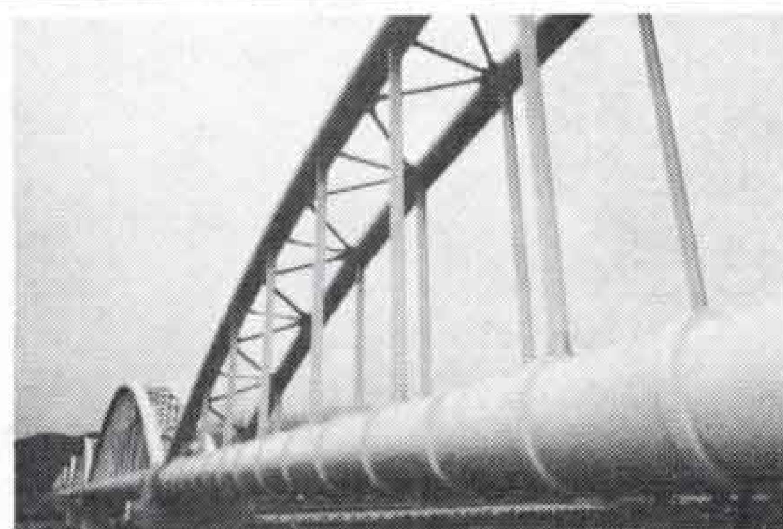
1日 木の宮公園運動広場完成=16,000平方㍍の敷地に野球場やバレーボールコートなどを工費1500万円で建設。／16日 東駿河湾工業用水道の水管橋が完成=水管橋の長さは1040㍍で2.2㍍の送水管が2本わたされており、完成の時には108万トンを送水。工費241億円で世界一の規模。／18日 竹山県知事が行政視察=田子の浦港や沼川などを視察
