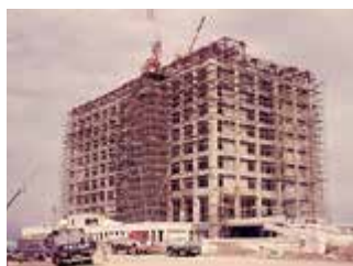
新庁舎建設工事（昭和44年）
