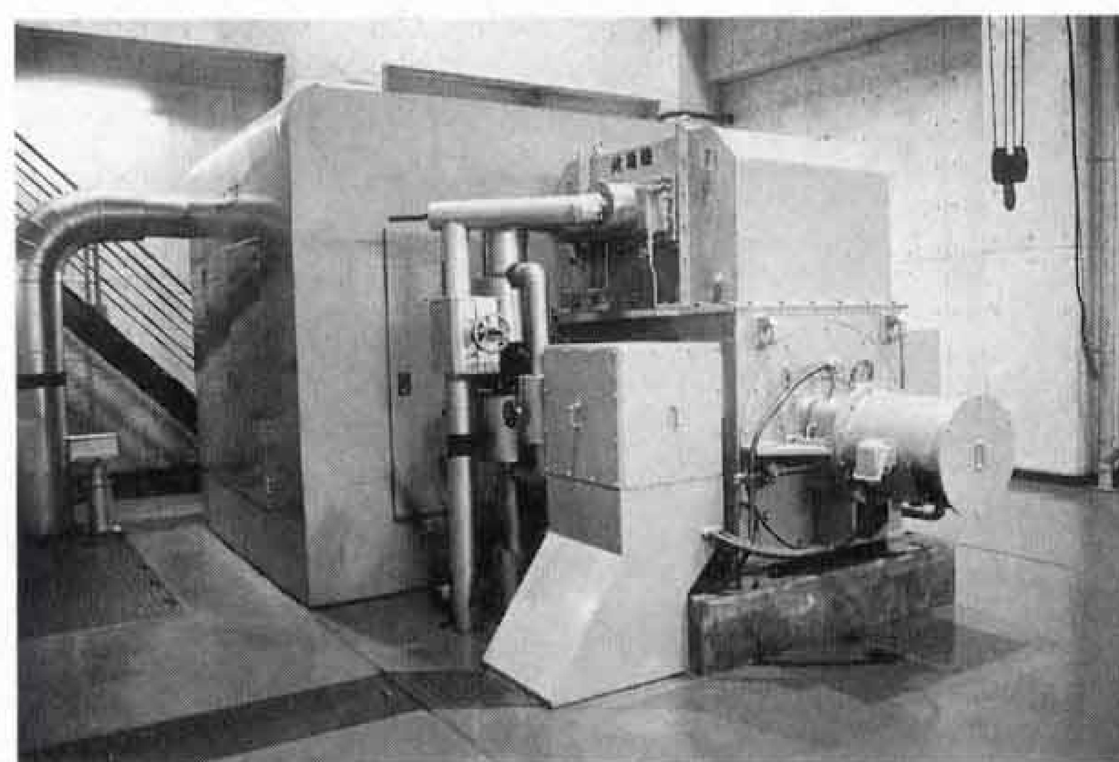
蒸気タービン発電機 蒸氣で
