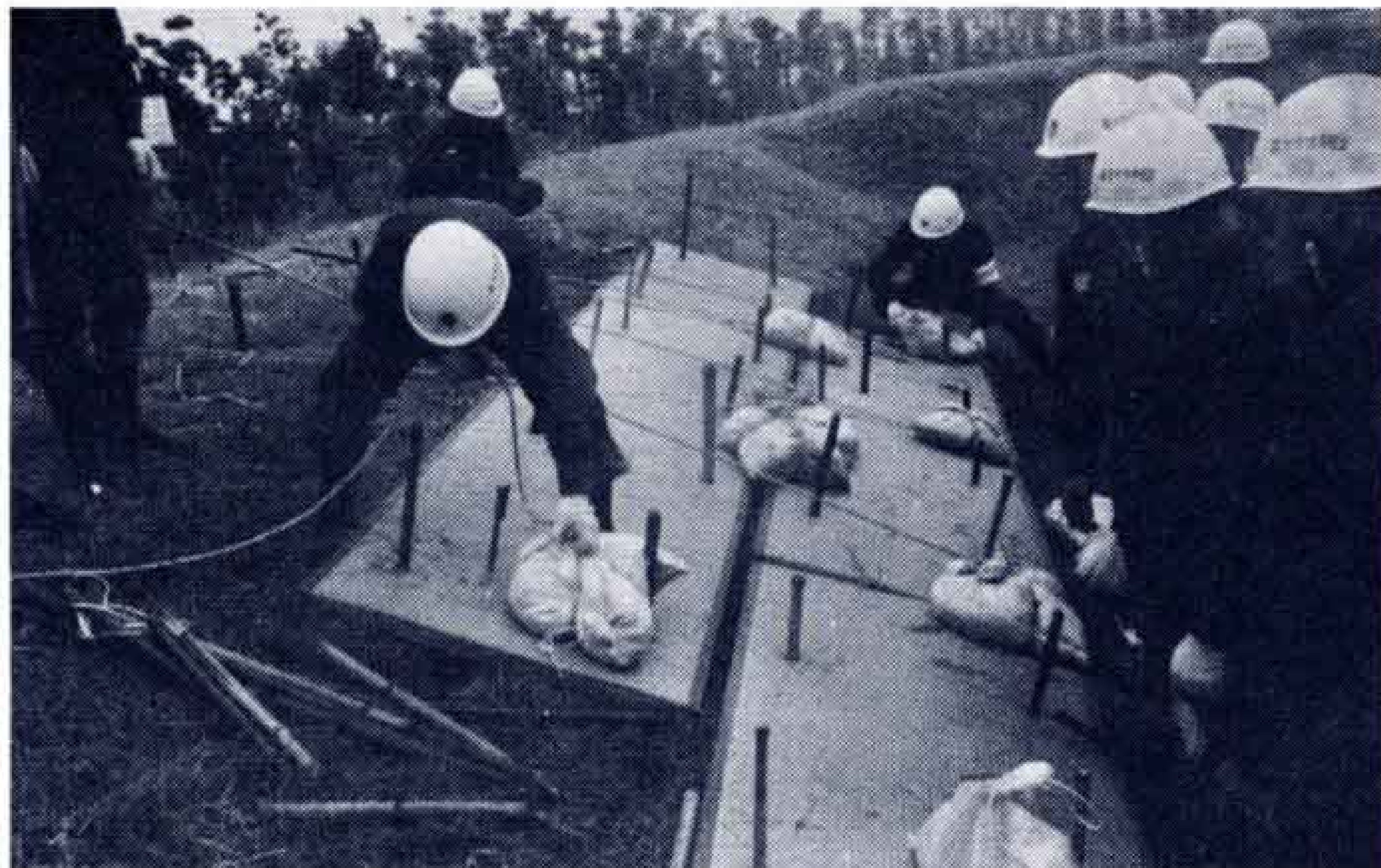
畳を使って堤防の亀裂を防ぐ畳張工法
