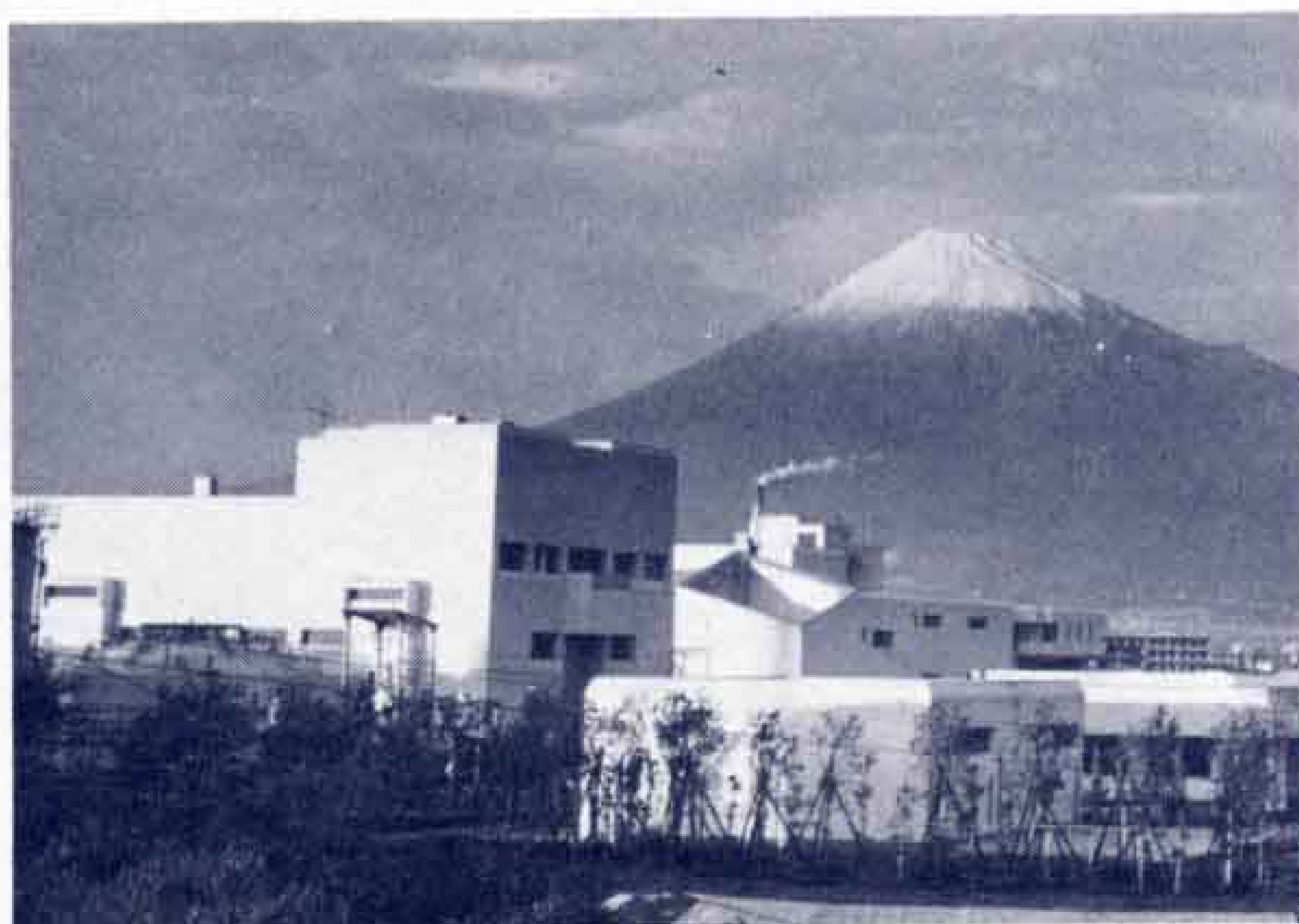
西部浄化センターが通水 待望の富士処理区公共下水道が稼動 (十月二十九日)
