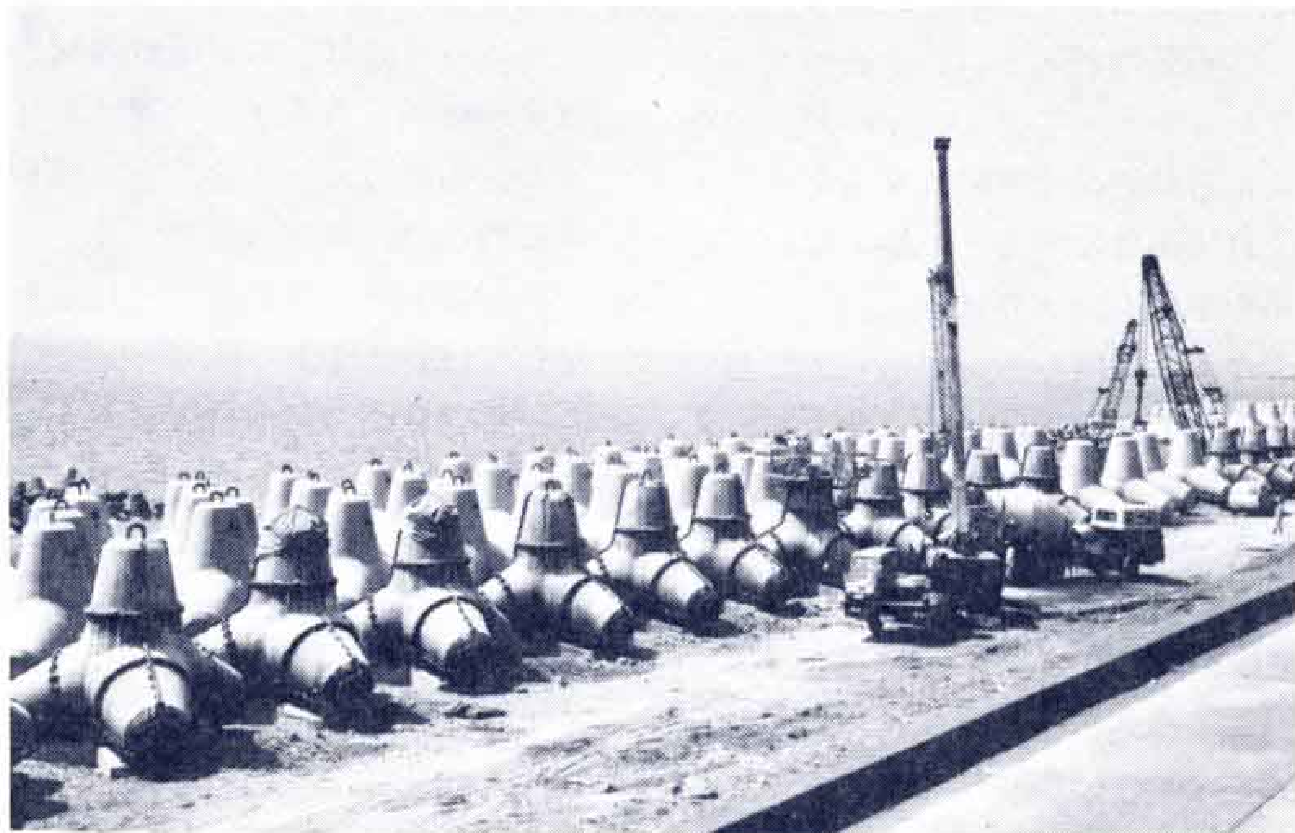
【異型ブロックが積みあげられていく元吉原海岸】
