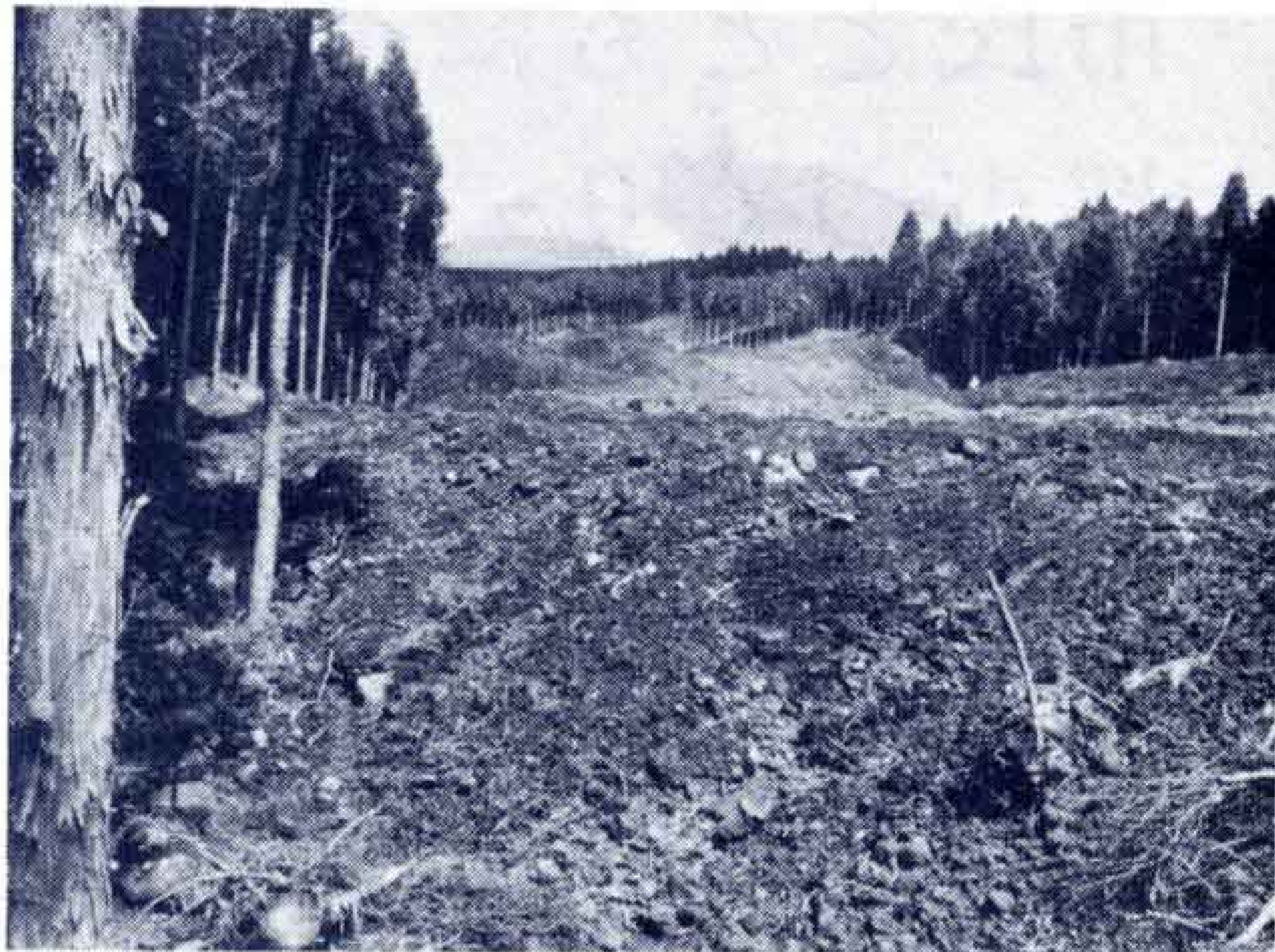
【市の方針を無視して工事を進めるゴルフ場】
